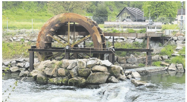
Eine defekte Achse bremst das Wasserschöpfrad im Hundig aus.
