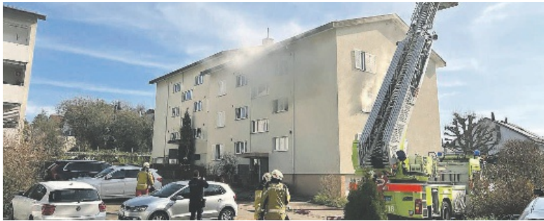
Dank der Rauchentwicklung konnte der Brandherd schnell lokalisiert werden.
