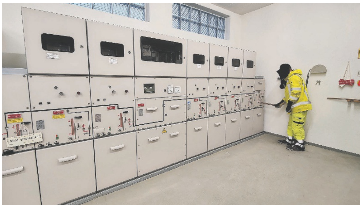
In einer Mittelspannungsschaltanlage wird mit Schutzausrüstung gearbeitet.
