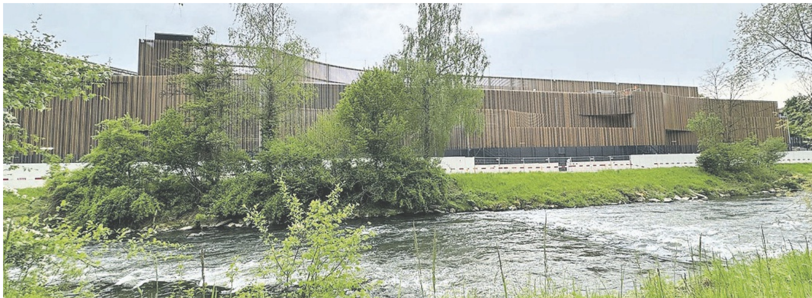
Das neue Datacenter beim «Riverside» kann voraussichtlich im Sommer in Betrieb genommen werden.
