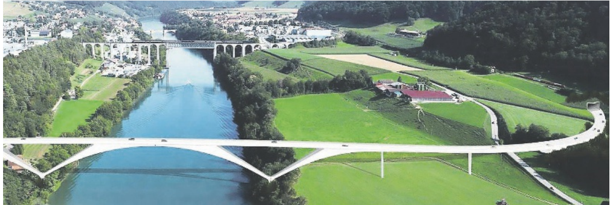
Kernstück der Umfahrung stellt eine neue Rheinbrücke dar, welche nur durch den motorisierten Verkehr genutzt wird. BILDER ZH.CH
